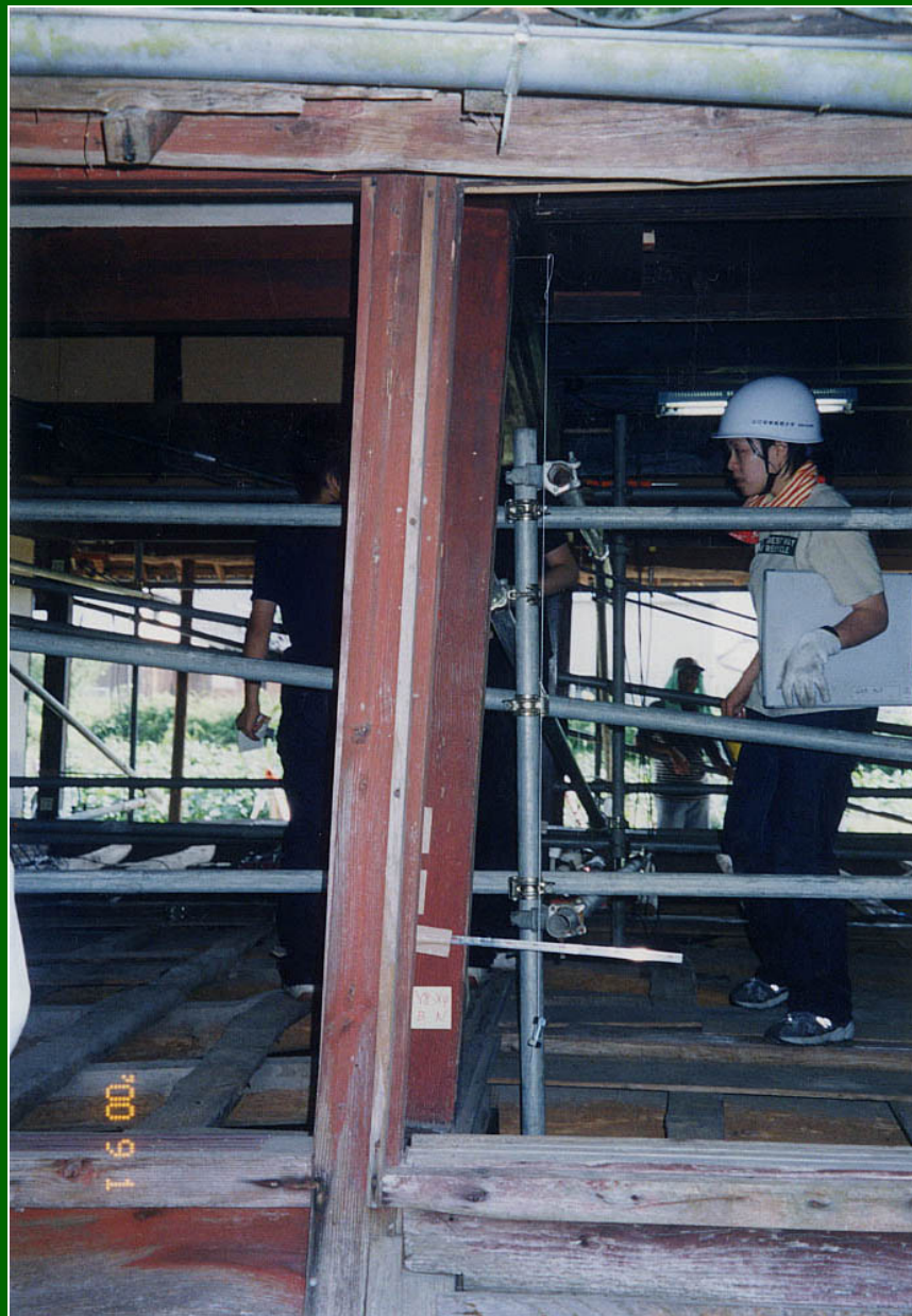
柱の傾斜 ( 1/60\text{rad.} )
