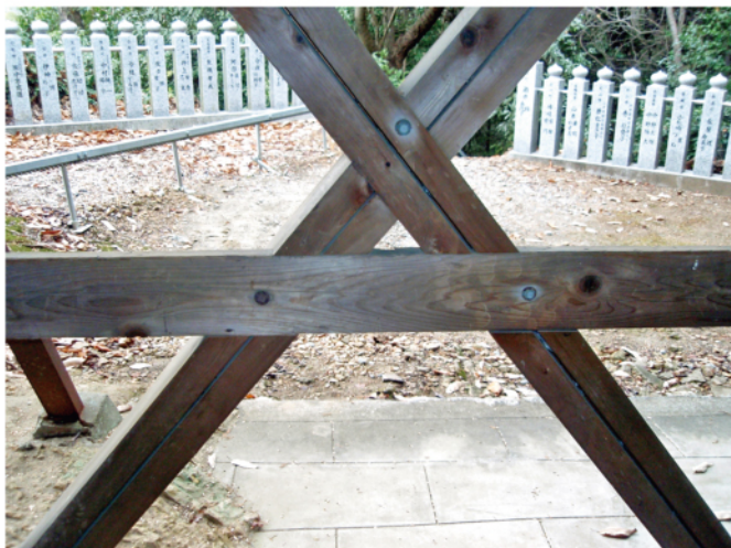
随求堂補強筋違と貫・東面
