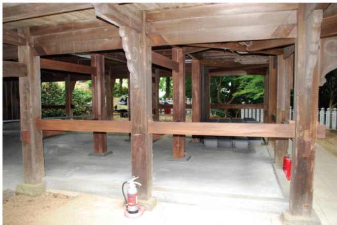
随求堂1階貫架構・東面北側
