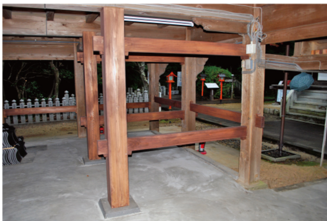
随求堂1階新設貫架構・東側内側北方向
