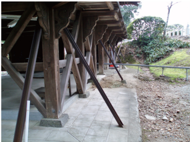
随求堂1階筋違とS造バットレス・西面
