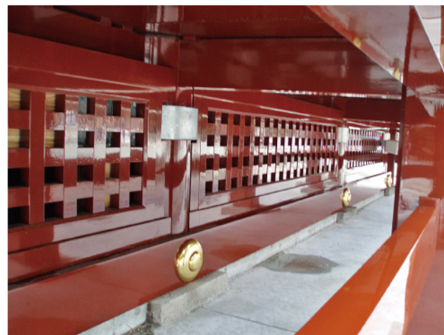
床下格子と耐震補強部・北面
