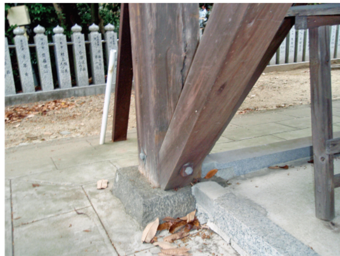
随求堂1階筋違と柱ボルト接合・北西隅
