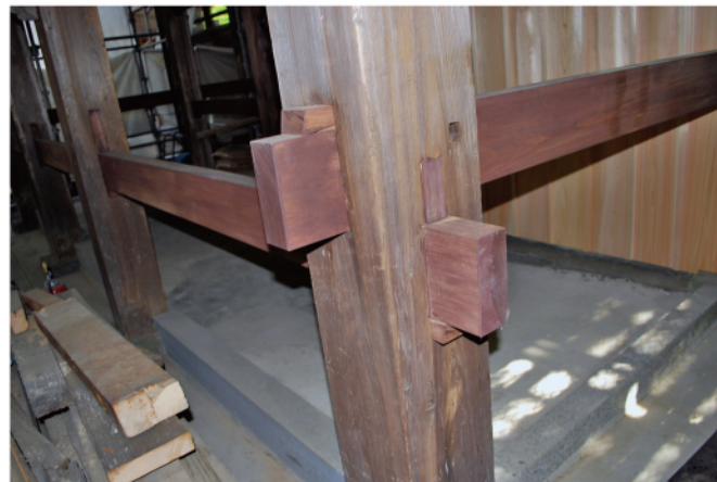
随求堂1階貫架構仕口段違い・北西隅
