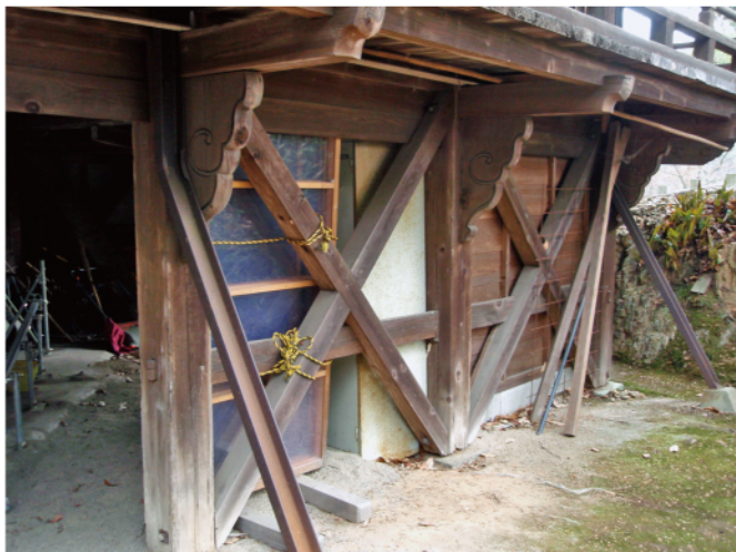
随求堂1階筋違とS造バットレス・西面南側
