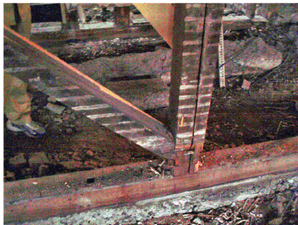
筋違接合部突付き仕口の事例
