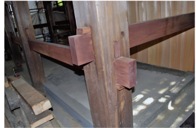
貫架構の施工例
