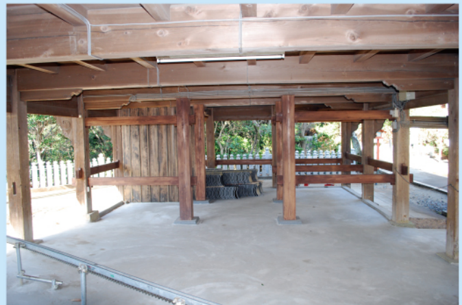
随求堂1階貫架構改修後・北方向
