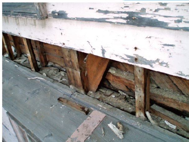
下見板外し筋違の確認事例
