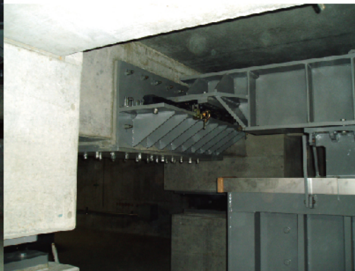
粘性ダンパー面外変形追従機構
