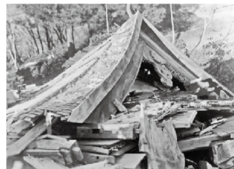
(a) 三階屋根の形状・東妻面
