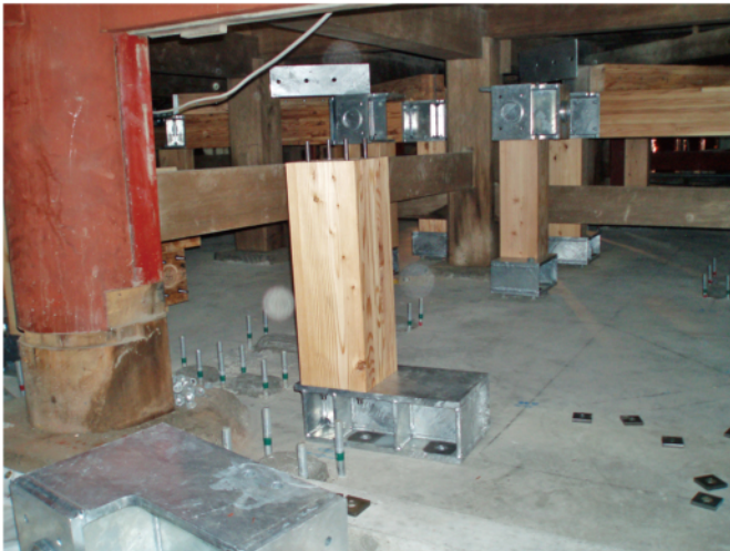
木造ラーメン架構組立・北面中央部
