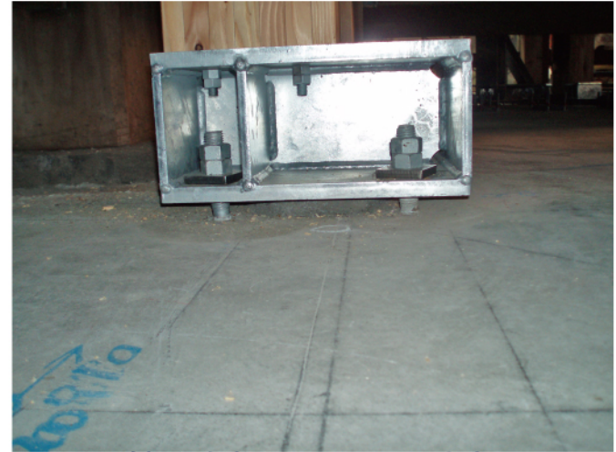
補強金物取付け・中央部
