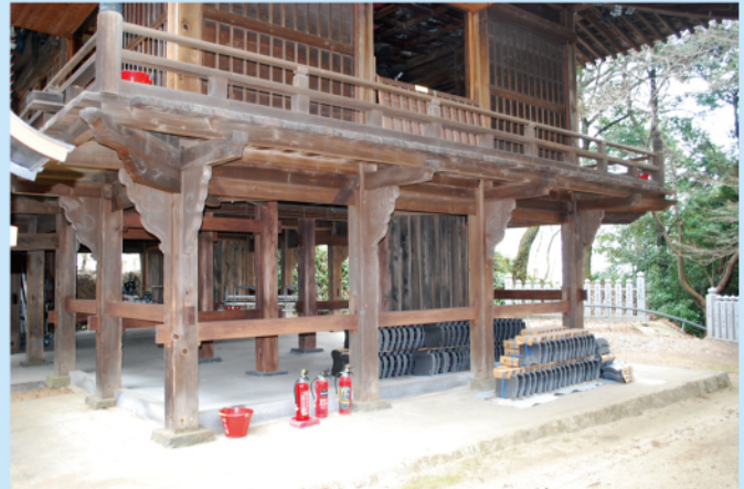
随求堂1階貫架構改修後・北面
