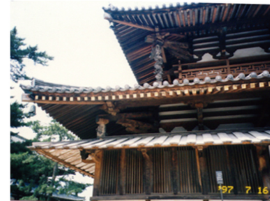
隅軒の束補強
