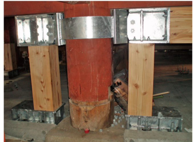
既存柱と木造ラーメン架構接合・西面中央
