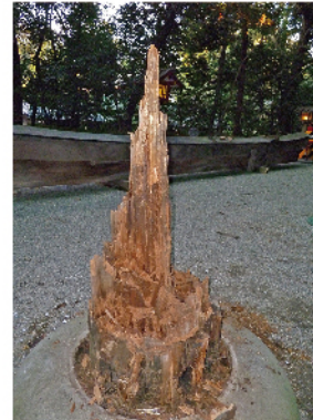
大鳥居の掘立て柱脚部の腐食 瀧川寺社建築
