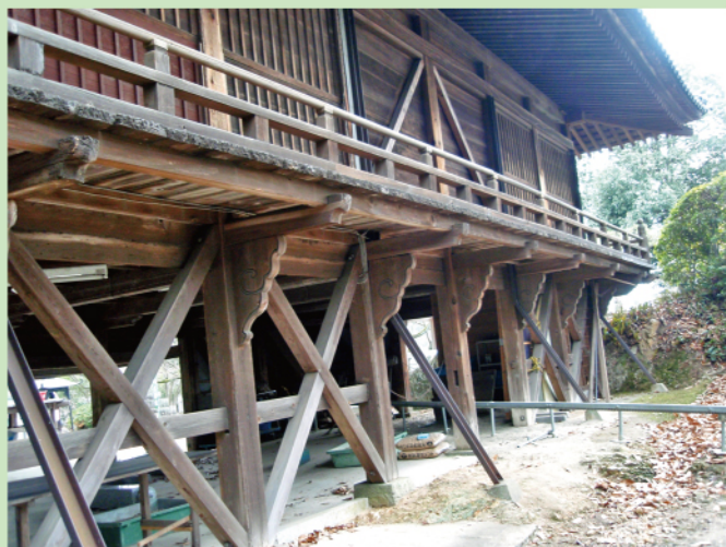
随求堂1階改修前・西面南方向
