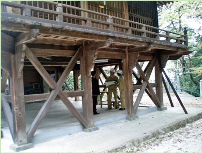
随求堂1階改修前・北面
