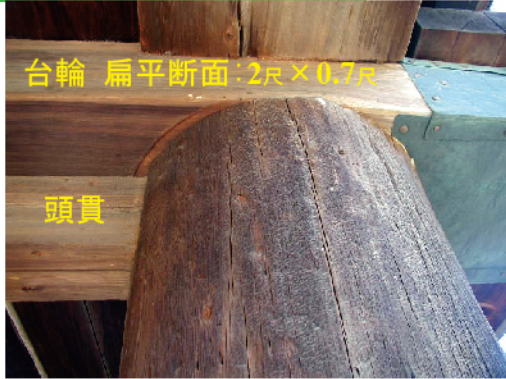
台輪底面-柱の移動痕跡
