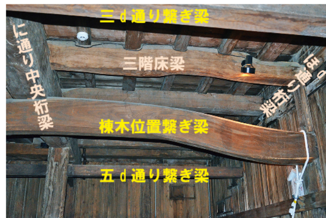
二階屋根棟木位置の繋ぎ梁：南端東方向
