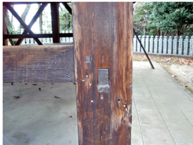
随求堂1階柱と貫仕口・西面中央
