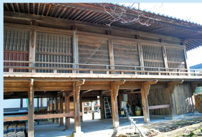
随求堂2階合板壁改修後・西面中央
