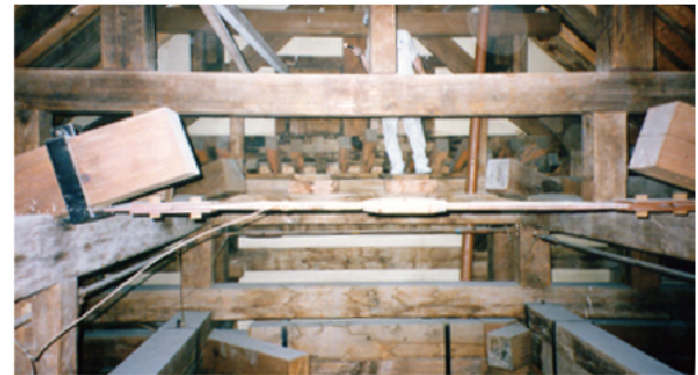
昭和修理でターンバックル補強
