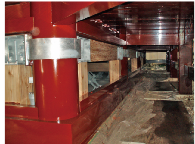
既存架構と補強架構・南面東方向
