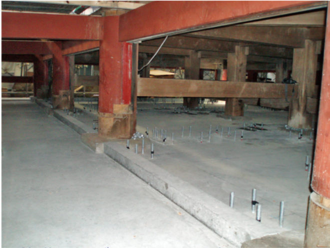
基礎スラブとアンカーボルト・西面
