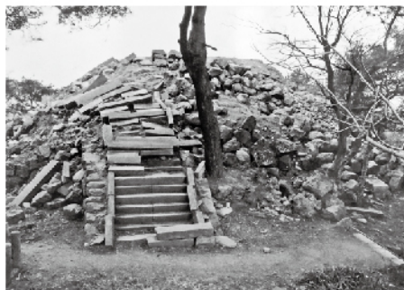
(b) 東面石垣崩壊
