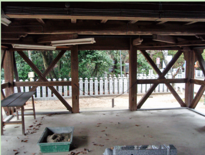
随求堂1階改修前・北方向
