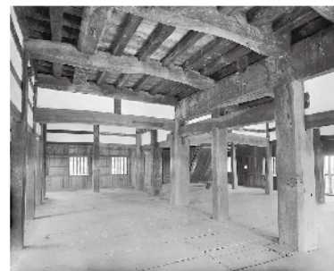
(a) 中央通りと小壁付き架構
