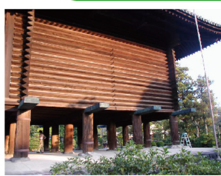
校倉壁外観・東面北倉 積層壁は台形断面 ( 1R \times 1R ): 20段積み
