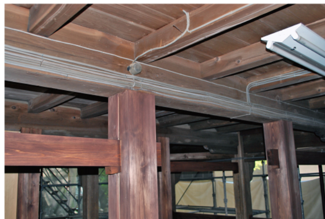
随求堂1階柱と貫仕口・北側中央追加柱
