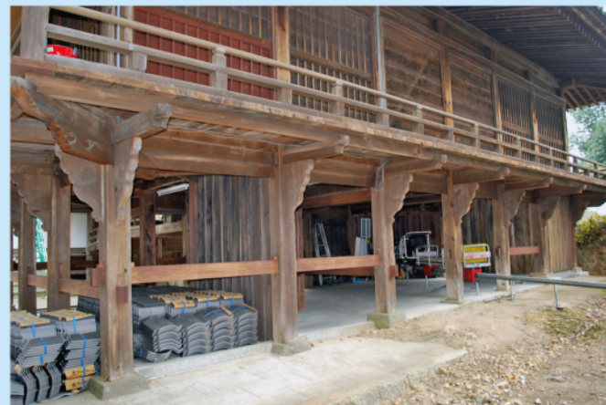
随求堂1階貫架構改修後・西面南方向
