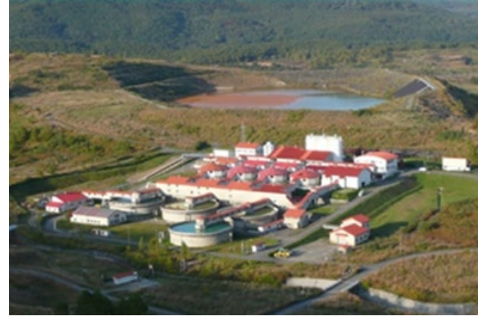
旧松尾鉱山新中和処理施設
