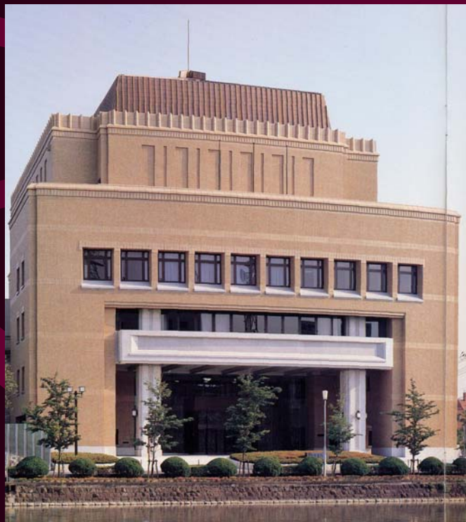
施工例(滋賀県議会棟)
