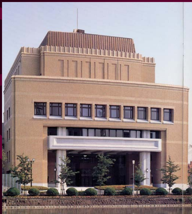
施工例(滋賀県議会棟)
