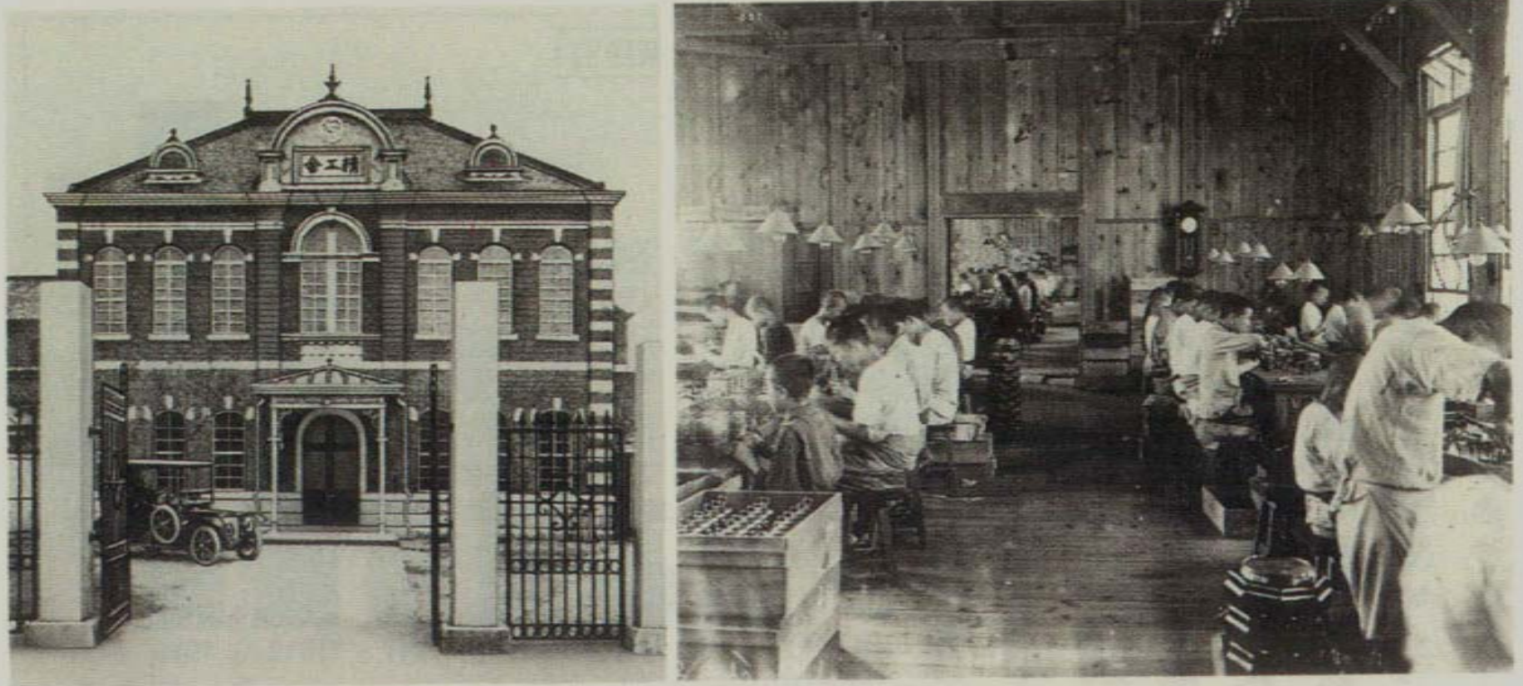
52 精工舎の時計製造 大正時代の目覚まし時計の組み立て作業場(右)と関東大震災前の事務館。
