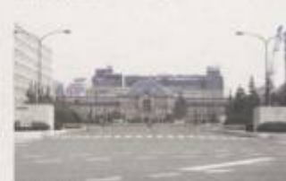
②東京駅 行幸通りからランドマークである東京駅を見る象徴的なビスタ景観。背景となる八重洲側の建物が駅舎のシルエットに重なっている。
