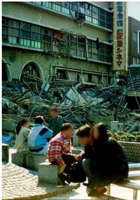
http://ja.wikipedia.org/wiki/ファイル:Hanshin-Awaji_earthquake_1995_338.jpg
