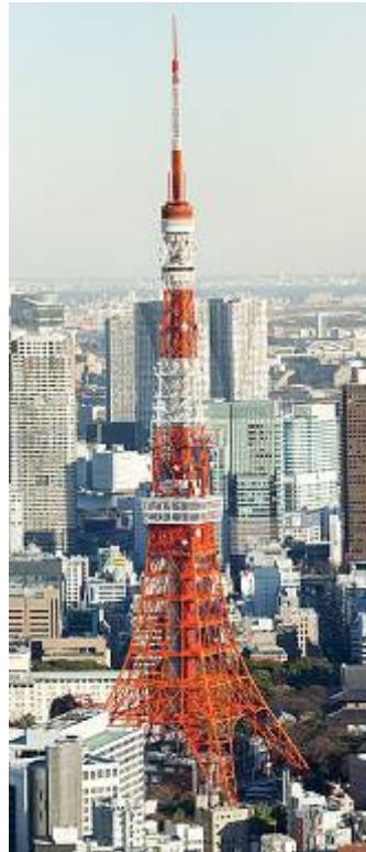
東京タワー 1958年完成 高さ 333m 鉄骨 4,200トン 耐震設計(関東大震災の2倍)
