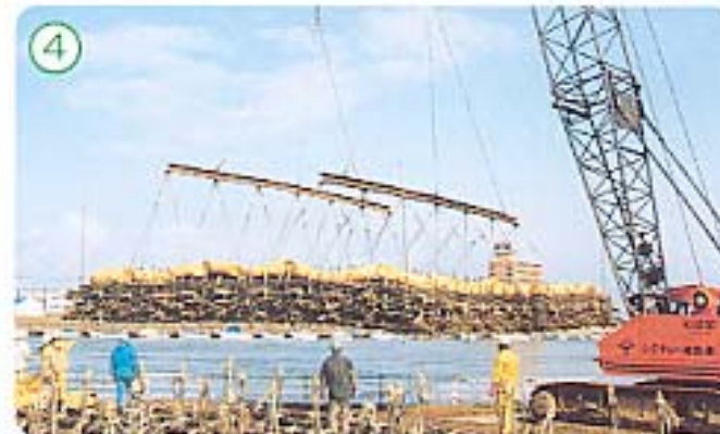
④ 組立完了した沈床をクレーンで吊上げる
