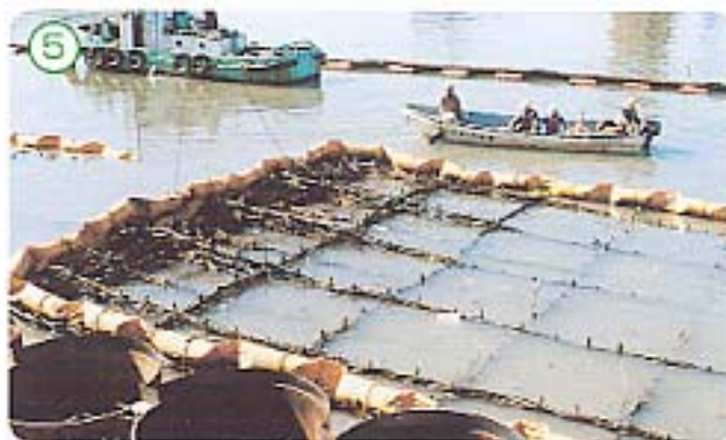
⑤ 粗朶沈床を川に沈設 位置を決め川に沈める
