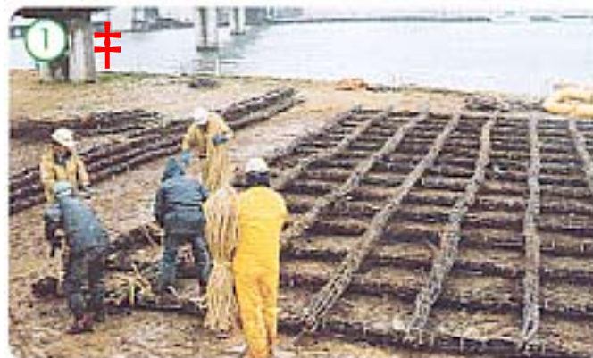
① 下格子組み 連柴1m真四角の樹形になるように組む
