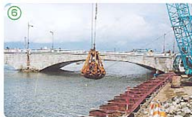
⑥ 沈石投入 クレーンで吊上げ位置を決めながら投石
