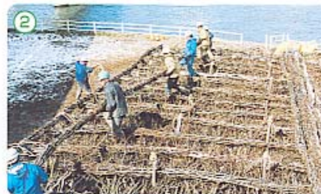
② 上格子組み 敷粗朶が済んだら下連柴の上に直角に上連柴を並べる
