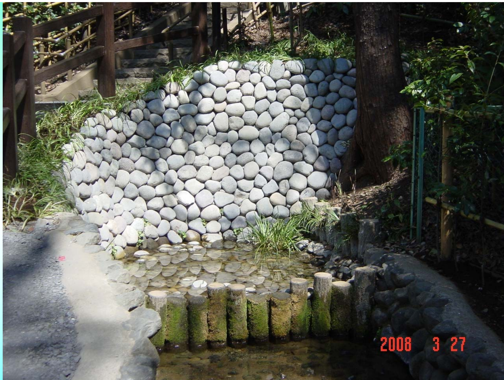
完成した擁壁(2008年3月)
