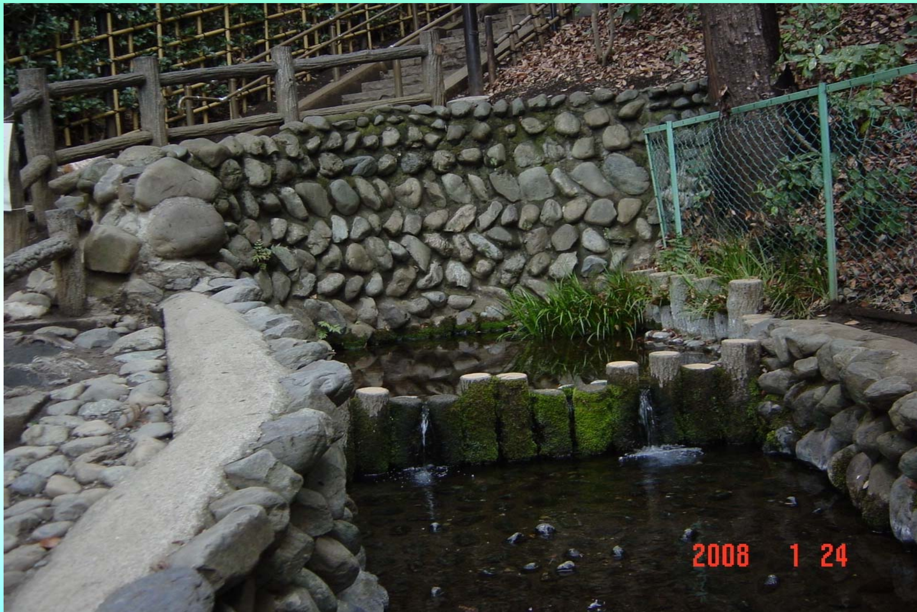
擁壁工事前 (2008年1月)
