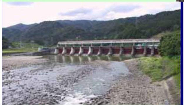
宮中ダム・JR東日本・1939年完成
