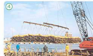
▲組立完了した沈床をクレーンで吊上げる
