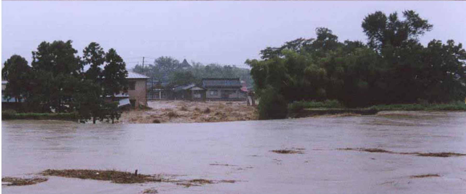
破堤直前・直後（7・13・石橋栄治撮影・提供）
