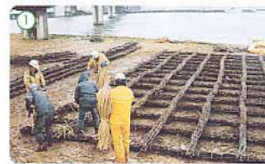
▲下格子組み 辺長1m異角角の枠形になるように組む
