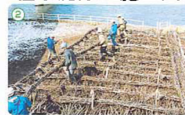
▲上格子組み 敷箱梁が沈んだら下沈床の上に直角に上連梁を並べる
