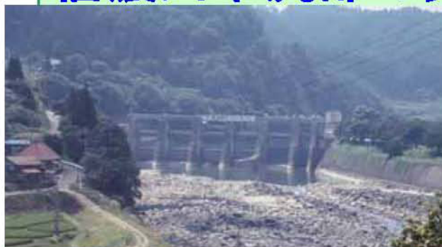
西大滝ダム・東電・1939年完成
