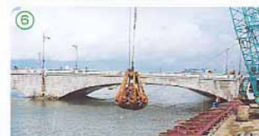
▲組立完了した沈床をクレーンで吊上げる
