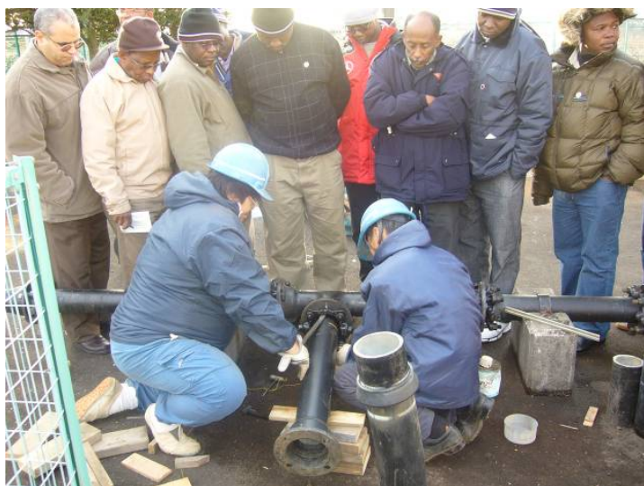
配水管接合講習（2009年1月）
