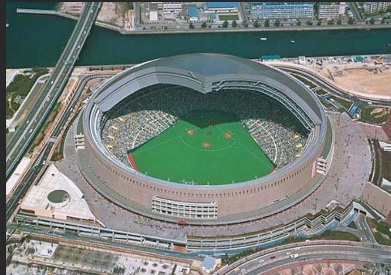
福岡ドーム (重量鉄骨構造) 屋根重量 12,000 ton
