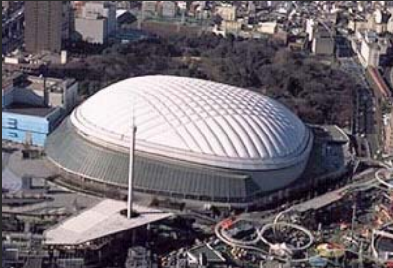
東京ドーム (空気膜構造) 屋根重量 570 ton
